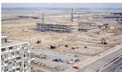
Baustelle: Das erste Erich-Kästner-Schulzentrum wurde ab 1977 errichtet. Heute ist das Gebäude schon wieder verschwunden – der Neubau wurde 2024 eröffnet. FOTO: STADT LAATZEN
